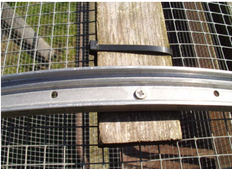
Detail: Verbindung mit Schrauben und Kabelbindern durch Speichenlöcher.
